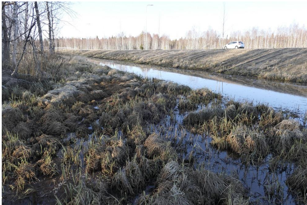
Kuva 5. Kohteen 1 soistumassa havaittiin 4 kutupalloa. Soistumassa oli 5-10 cm syvää vettä.
